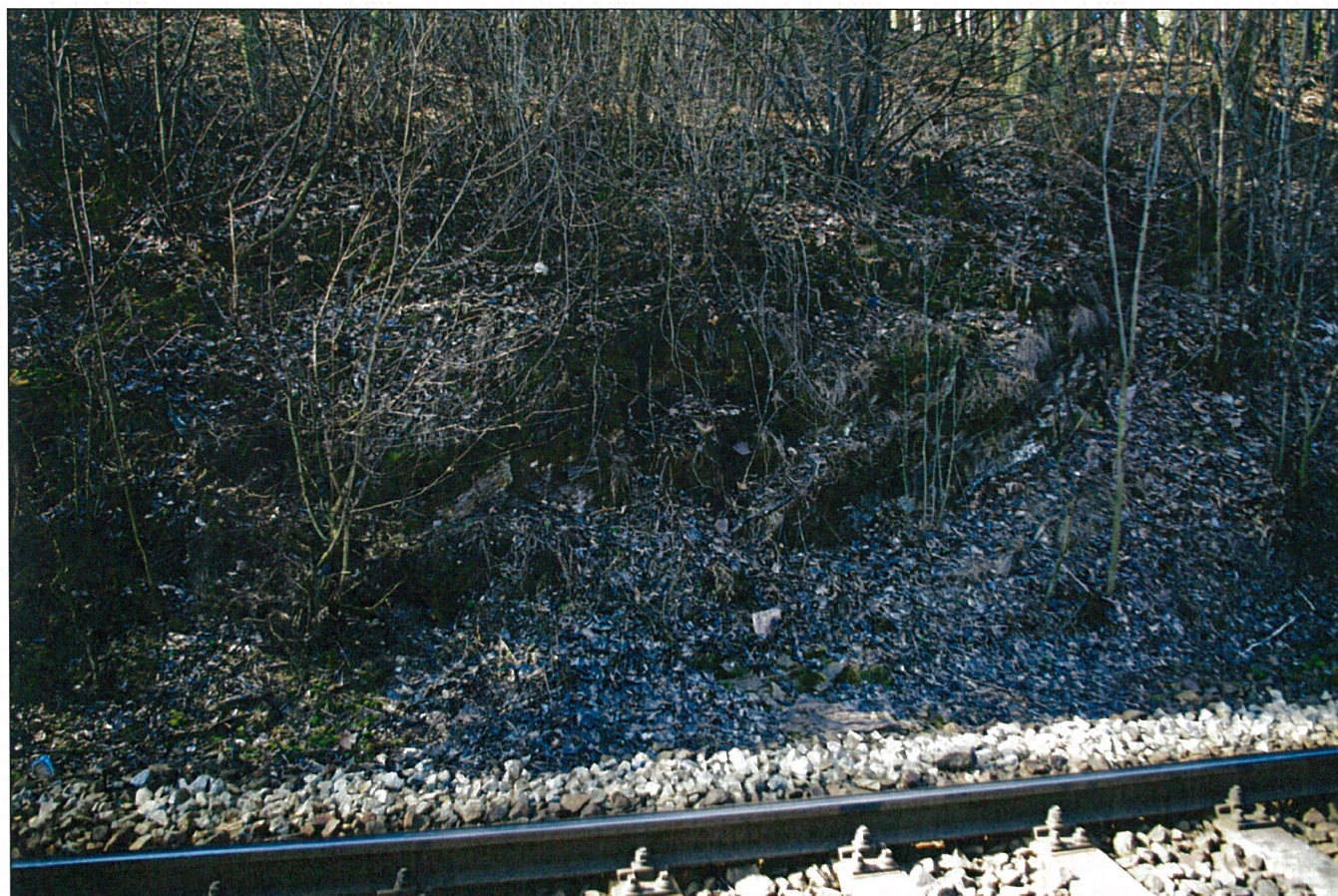
Foto – 6 Pohled na levý svah v km 8,660 s částečně odkrytými pískovci s polohami prachovců a jílovců.
