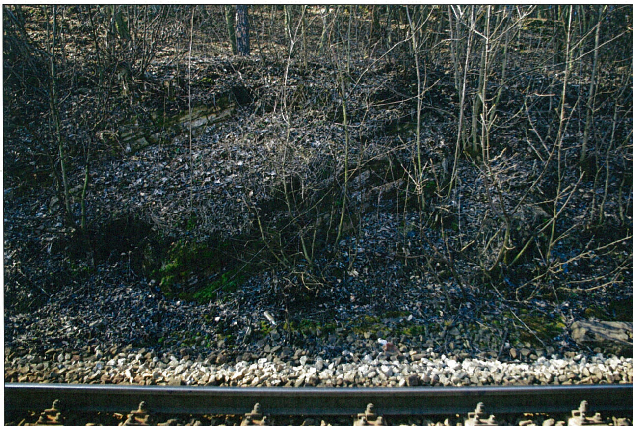
Foto – 8 Pohled na levý svah v km 8,685 s částečně odkrytými pískovci s polohami prachovců a jílovců.
