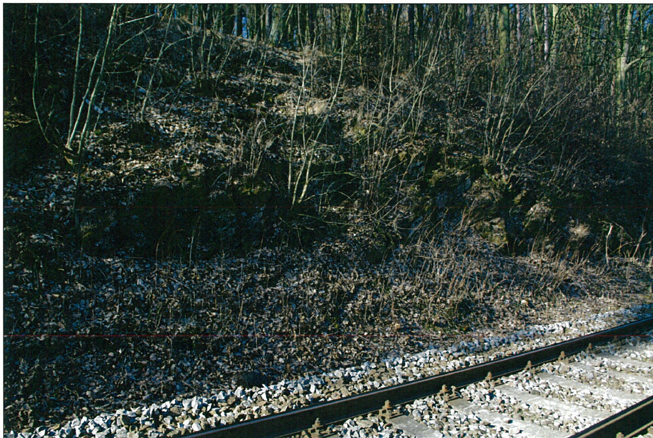
Foto – 11 Pohled na levý svah v km 9,130 – 9,145. Střídání pískovců s prachovci.
